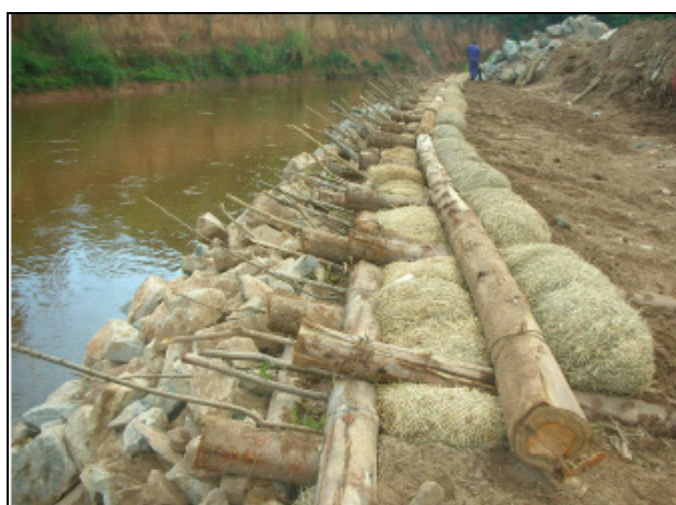
Figura VII.6.3.5.1-5 – Exemplo do uso de madeira, biomanta, aterro compactado e estacas vivas na proteção de margens de cursos d'água
