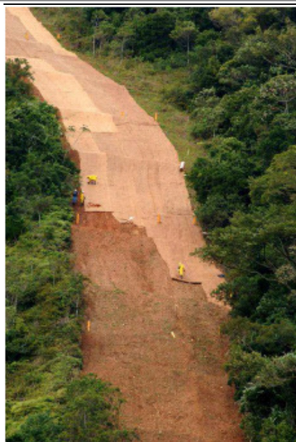
Figura VII.6.3.5.1-4 – Exemplo do uso de biomanta para a proteção de superfícies expostas
